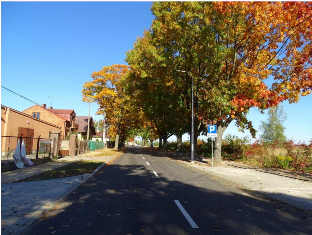
Przebudowana ul. 11 Listopada.
