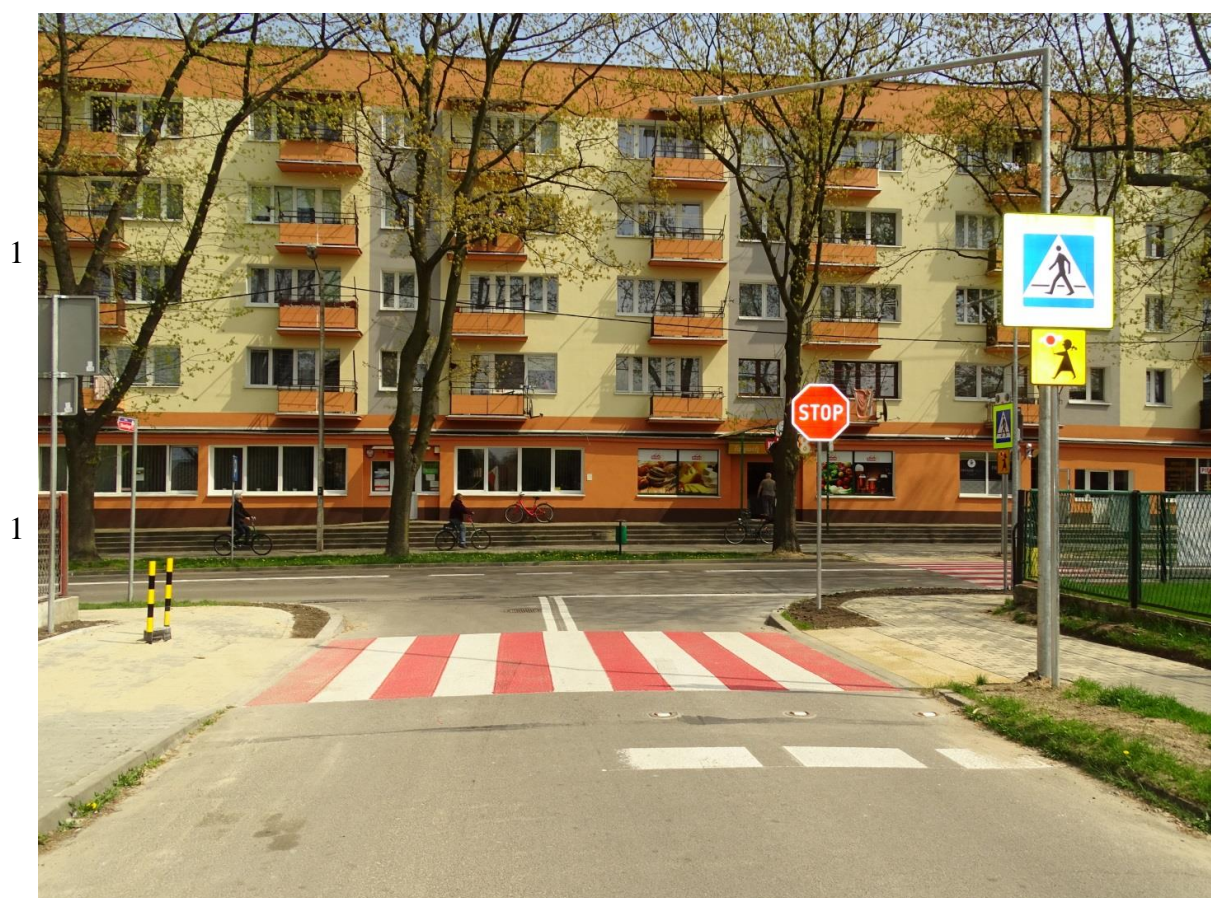
Bezpieczne przejście w ul. Sikorskiego.
