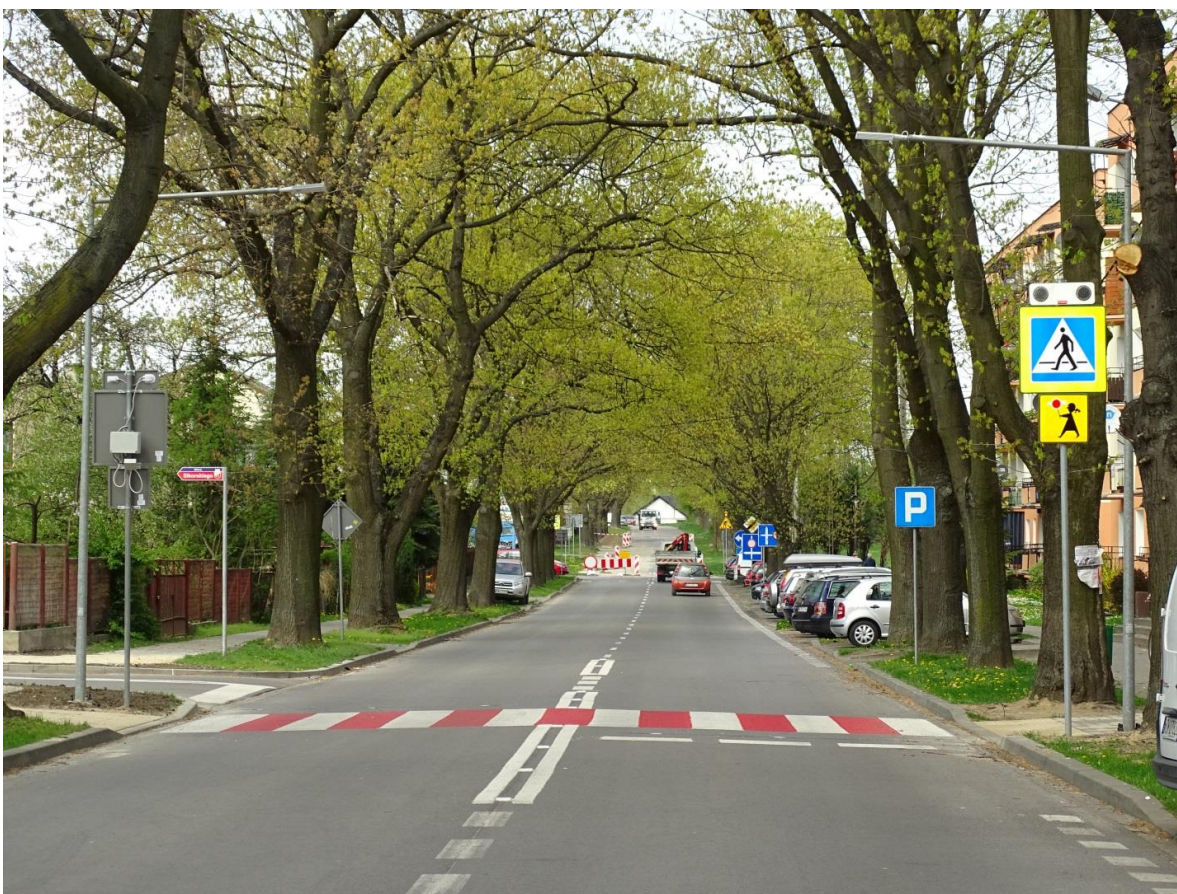
Zmodernizowane przejście w ul. 11 Listopada.
