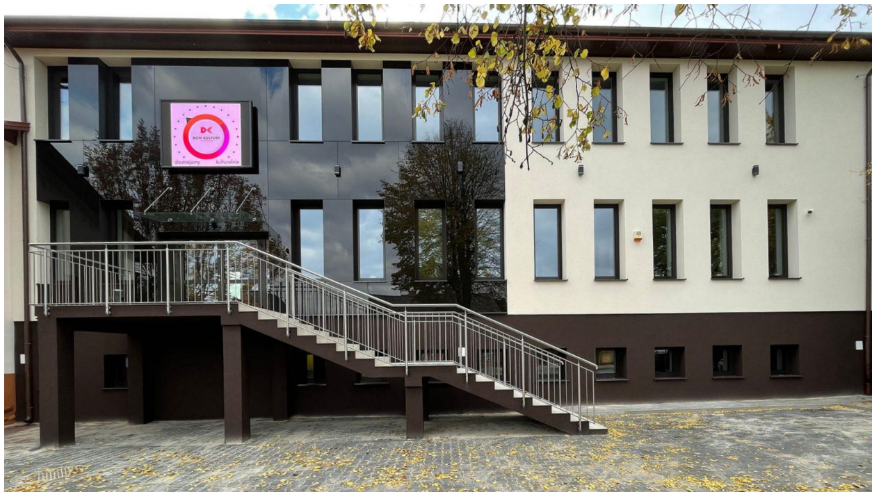
Budynek Domu Kultury po przeprowadzonej termomodernizacji.
