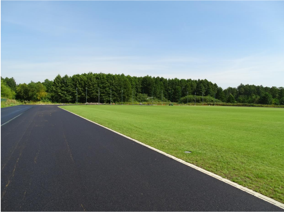
Stadion miejski w trakcie prac – zdjęcie wykonane w sierpniu 2022 r.
